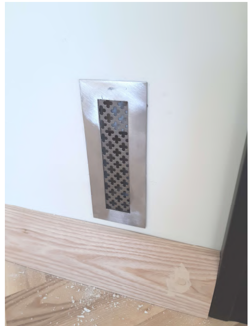
2 pav. Parketo ventilacijos grotelės
